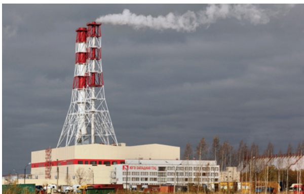
МЮГО-ЗАПАДНАЯ, ТЭЦ г. Санкт-Петербург
